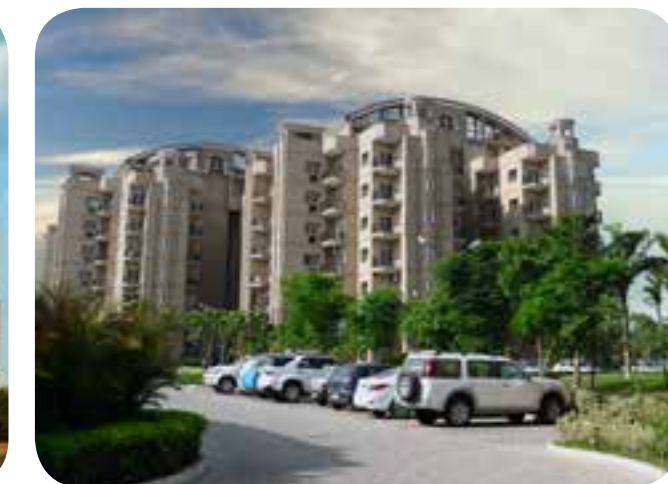
ATS PRELUDE Dera Bassi
